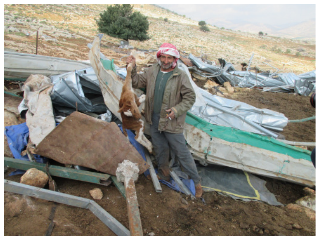
Fayas il Hammed mit einem Kalb, das bei der Zerstörung der Ställe getötet wurde
